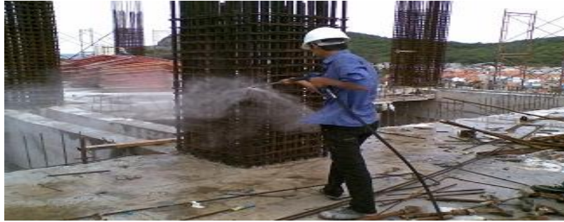
Hình 3.3. Vệ sinh cột thép cột bị rỉ sét
